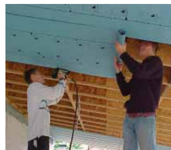
De gebouwschil op gelijkvloers en verdieping bestaat uit een houtskelet opgevuld met strobale van 750 x 550 x 350 mm
