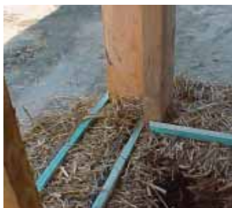
De gebouwschil op gelijkvloers en verdieping bestaat uit een houtskelet opgevuld met strobale van 750 x 550 x 350 mm
