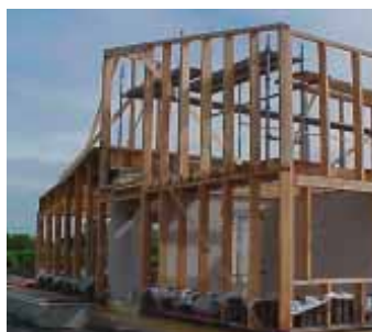
Het strobalegebouw is langs buiten afgewerkt met kalkleem en hout, langs binnen met leem en kleifinisch
